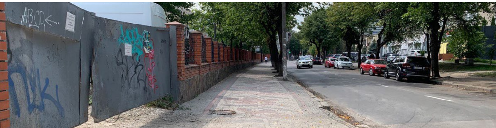
Фото 1: Будівництво за адресою вул. Коновальця, 35.
